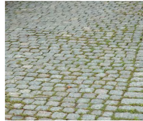
↑ žulová dlažba zatravněná, kostka drobná štípaná 8/11
