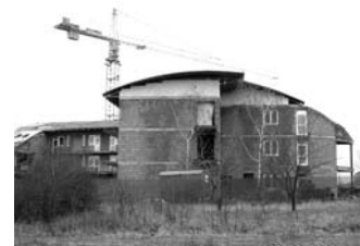
↑ Stavba domu s chráněnými byty Libuš.
