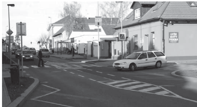
↑ Přechod poblíž autobusové zastávky U Libušské sokolovny byl vytipován v projektu Bezpečné cesty do školy k úpravám – na snímku v první fázi po zvýraznění zdrsňeným barevným povrchem. Později byly doplněny ještě dělicí ostrůvky.
