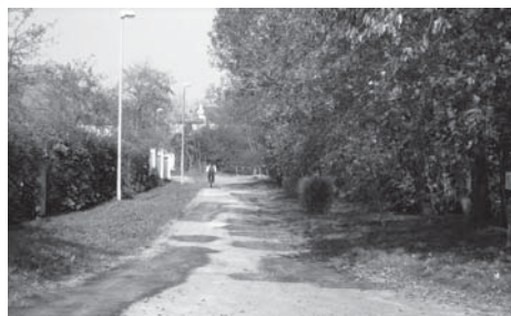
↑ Opravená ulice K Vrtilce...
