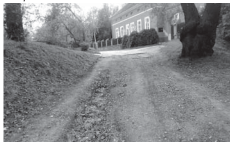
↑ Zátoňská před opravou...
