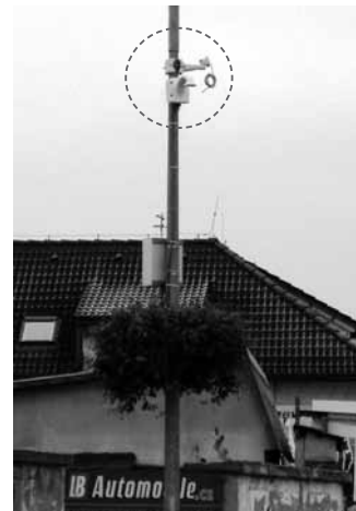
↑ Bezpečnostní kamera na křižovatce Libušské a Dobronické ulice před instalací. Foto: archiv ÚMČ Praha-Libuš
