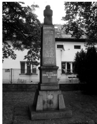
Pomník před opravou, s chybějící tabulkou na podstavci.
