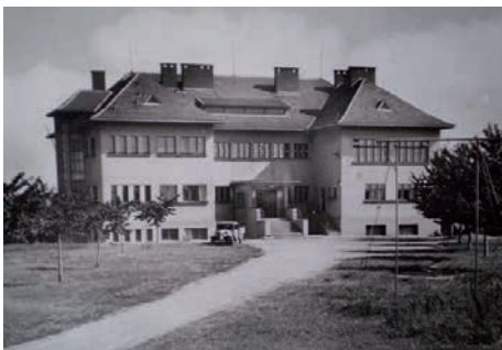
Původní budova Základní školy Meteorologická
