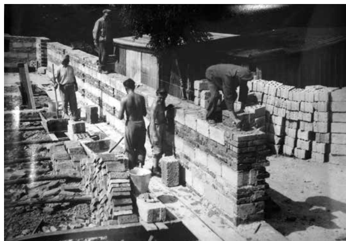
Typické letní odpoledne plné dobrovolníků při stavbě školičky.
