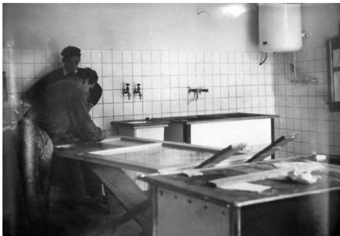
Dokončovací práce a vybavení nové kuchyně.
