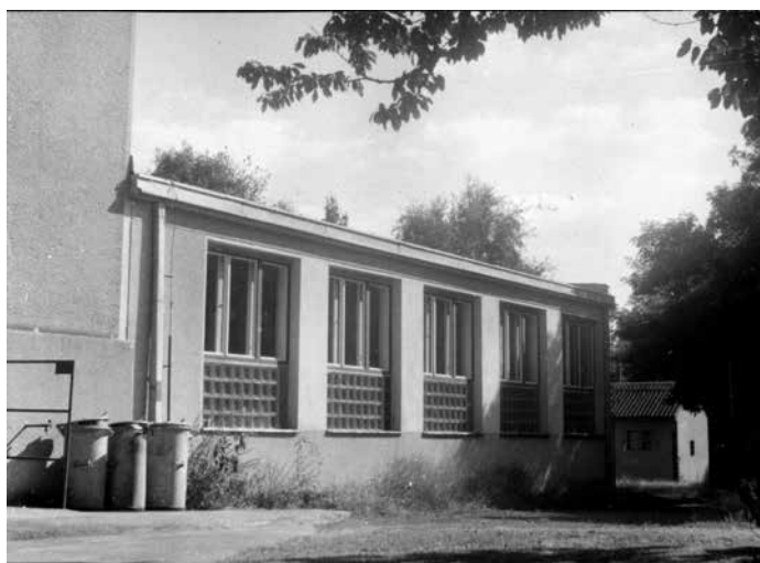
Přístavba chodby a tělocvičny z let 1972–1975. Fotografie po dokončení.
