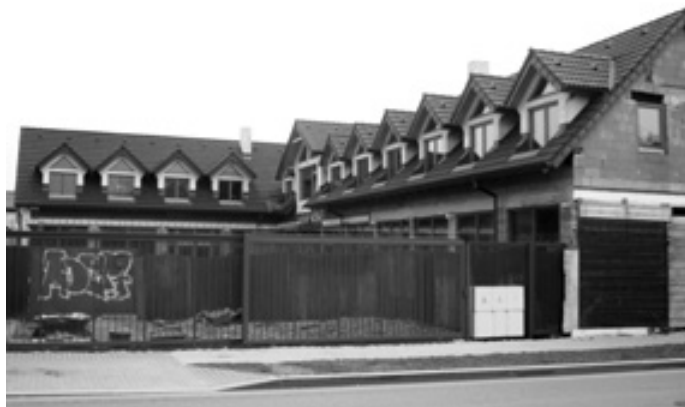
Stav objektu k 28. 3. 2014. Foto: Zdeněk Kříž
