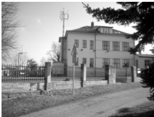
Škola před zahájením stavby...
