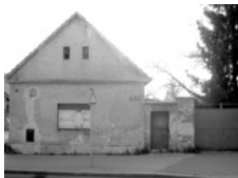
Dům Libušská 41 určený k demolici. Foto: Šárka Pichová
