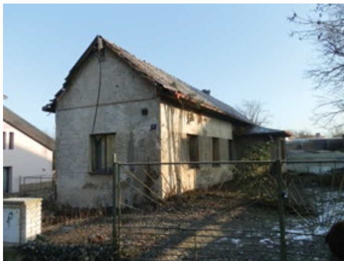
Obecní pastouška – stav v červnu 2015 před plánovanou demolicí.
