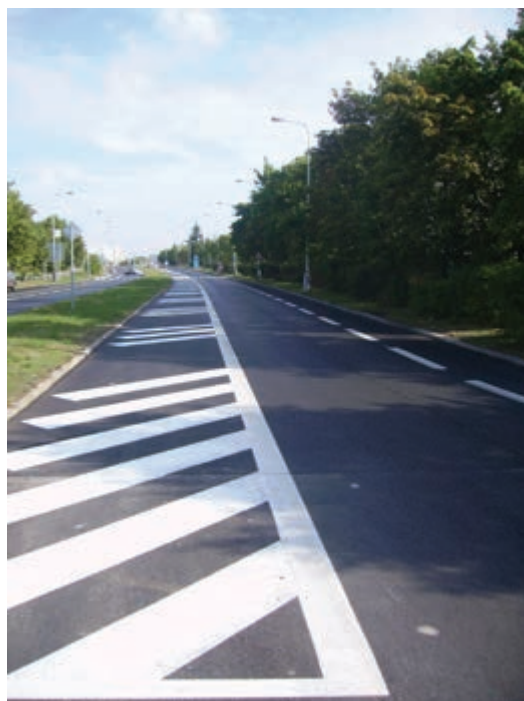
Zúžení vozovky za přechodem pro chodce a zkrácení levého odbočovacího pruhu nedává smysl, pokud jeho účelem nemá být znemožnění předjíždění. V takovém případě je nový povrch v plně šíři vozovky zbytečný.
