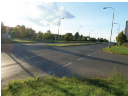
Původní stav vozovky Novodvorská. Ve srovnání s okolím nevyhlíží v nijak kritickém stavu.
