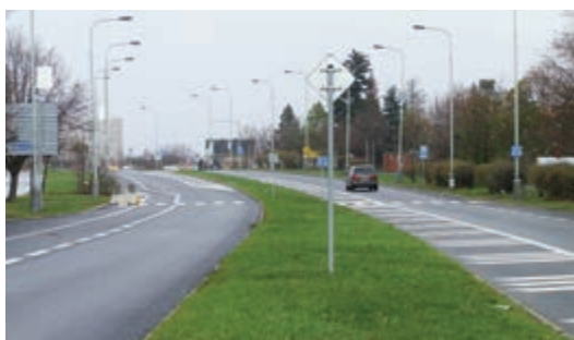
V těchto místech má být – snad v dohledné době – vystavěna tramvajová trať, která by tak podstatnou část první etapy rekonstrukce znehodnotila. Vedena má být v rozšířeném prostředním ostrůvku ulice.
