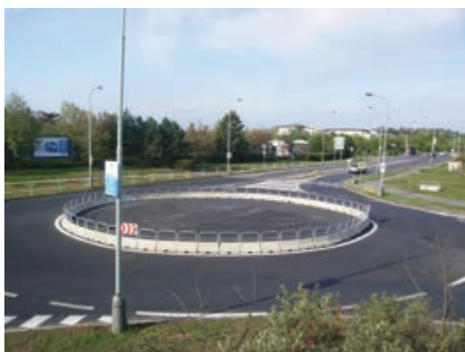
Nový povrch nepřístupného vnitřního prostoru kruhového objezdu o ploše cca 250 m 2 .
