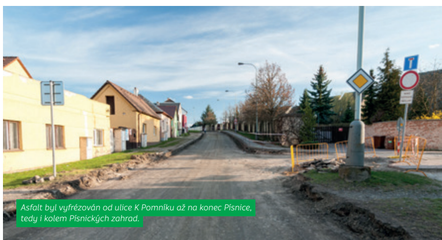
Od ulice Na Konečné začaly práce na uložení kanalizace, na kterou budou napojeny už i poslední domy v Písnici, kde zatím chyběla.
