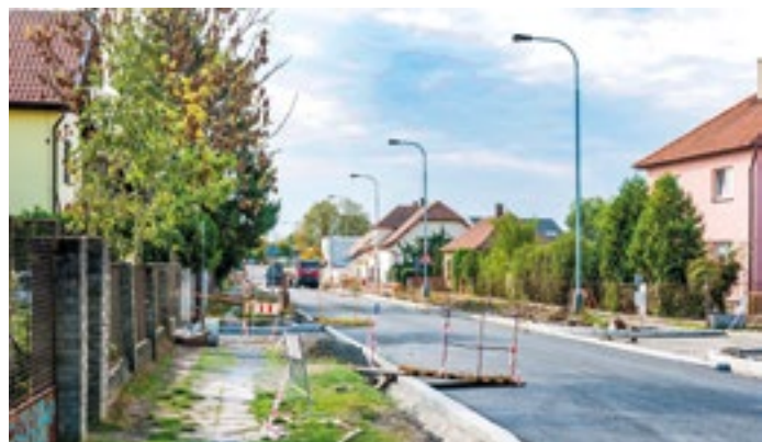
Firma Eurovia i během stavby zachovává maximální přístup k objektům.
