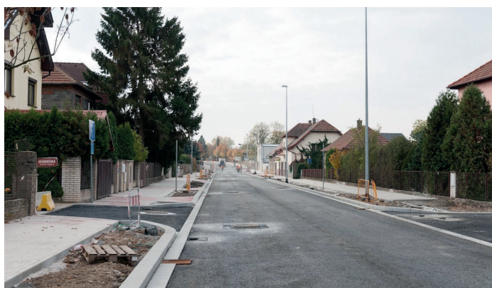
Poslední rekonstruovaná část v Písnici, od ulice K Mejtě po ulici K Vrtilce, se v říjnu dočkala finálních vrstev asfaltu.
