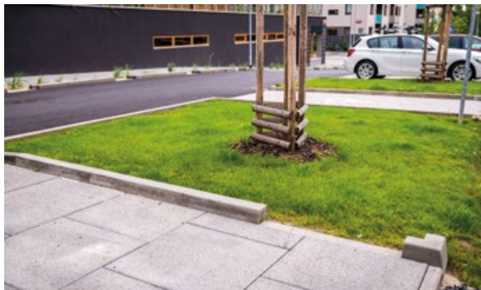
▲ Přerušované obrubníky pomáhají zadržet vodu v místě (Praha-Hloubětín). Foto: Nadace Partnerství (Vojta Herout)
